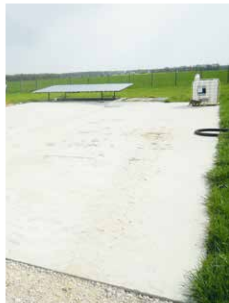
Exemple d'aire de lavage/remplissage financée par les Agences de l'Eau.
